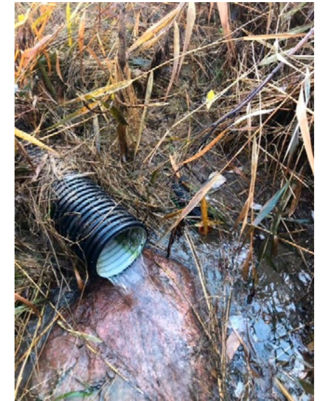
Utllysning för täckdikning under 2022.
